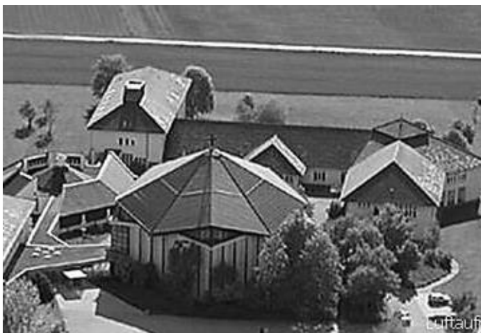
Der Ort der Entscheidung: Liebfrauenhöhe bei Rottenburg
